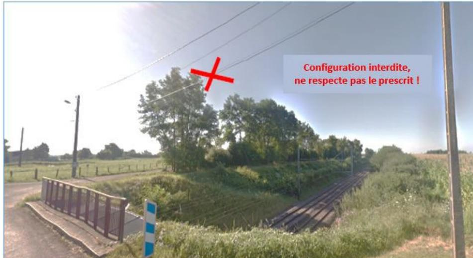
**Rappel :** Comme le schéma précédent et la photo ci-dessus l'indiquent, une fibre optique, sur supports communs, ne peut pas surplomber une voie ferrée électrifiée. Dans le cas particulier d'une voie navigable, Enedis n'autorise pas le partage de ses supports en traversée.
