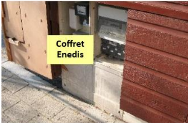
Branchement provisoire sur terrain totalement pré-équipé ⇒ fixe
