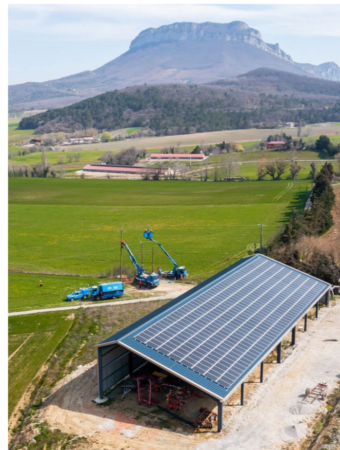
Chantier de techniciens sous tension TST HTA pour raccorder les panneaux photovoltaïques d'un client agriculteur à Crest, dans la Drôme : techniciens sur une nacelle pour remplacer un poteau électrique sans coupure d'électricité.
