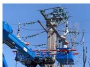
Le **robot télécommandé** permet de réaliser les travaux à distance et sans risque sur les lignes 20 000 volts sous tension. Révolution technologique, cette solution permet de gagner en sécurité pour les techniciens, est moins coûteuse que les solutions utilisées traditionnellement et réduit l'empreinte carbone liée à ces travaux.
